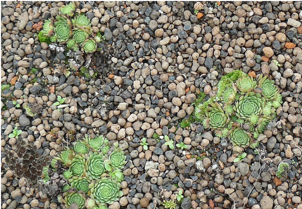
Obr. 1: Hrubozrnný keramzit se často separuje na povrchu a tím se snižuje tloušťka efektivní vrstvy substrátu
